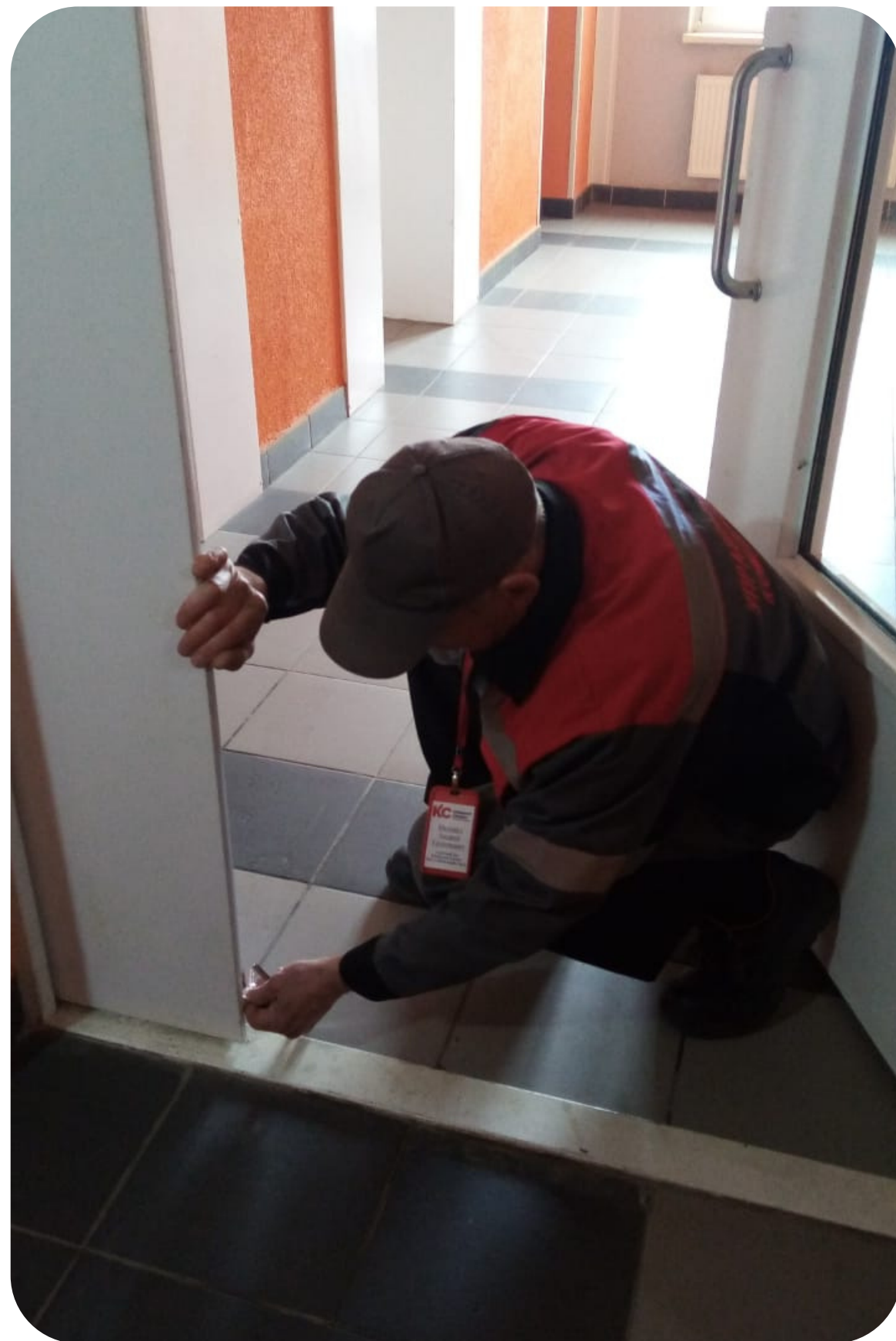
РЕГУЛИРОВКА ДВЕРИ ВХОДНОЙ ГРУППЫ
